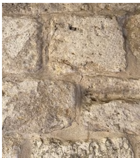
Desplacación de morteros de junta por cristalización de sales. Museo Nacional de Escultura de Valladolid. Foto: Ana Laborde
