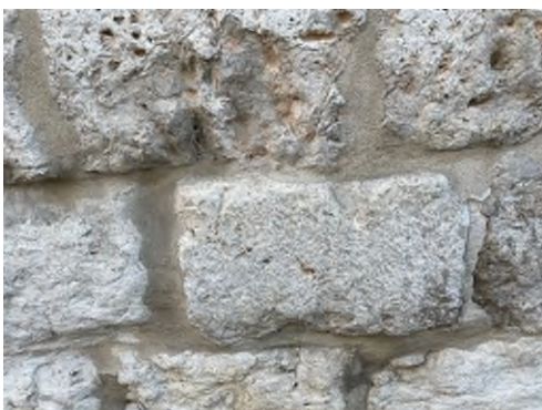
Mortero de rejuntado entre sillares calizos. Museo Nacional de Escultura de Valladolid. Foto: Ana Laborde
